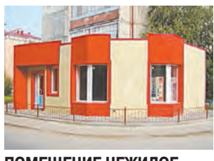
ПОМЕЩЕНИЕ НЕЖИЛОЕ, 7 мкр., 1/5п, 89,8 кв.м, отдельная входная группа, ремонт, подвесной потолок, новая сантехника. Цена 4 млн 550 т.р. Т. 8-919-940-88-99.
